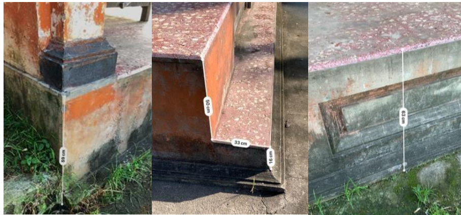
Gambar 4. 34 Kondisi Eksisting Bataran Bale Tajuk di Banjar Nyamping
